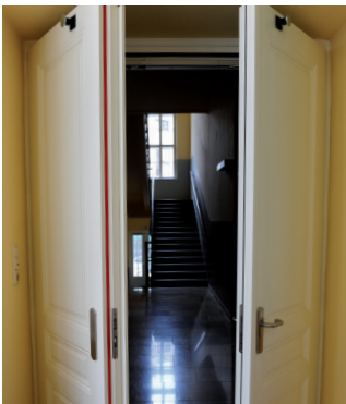
2-flügelige Brandschutztüre EI²30C mit Panikfunktion EN 179. Optik wurde an den Altbestand angepasst. Inklusive Magnethalter: Dieser löst im Brandfall die Türen und mittels Schließfolgeregler werden beide Türflügel richtig geschlossen.
