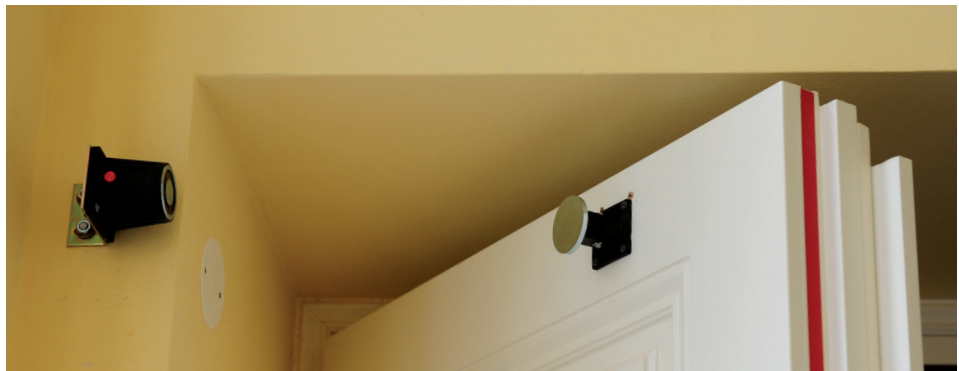
2-flügelige Brandschutztüre EI²30C mit Panikfunktion EN 179. Optik wurde an den Altbestand angepasst. Inklusive Magnethalter: Dieser löst im Brandfall die Türen und mittels Schließfolgeregler werden beide Türflügel richtig geschlossen.
