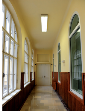
Feuerhemmende F90 Fixverglasung mit Kämpfer (F90 = 90 Minuten Feuerwiderstandsdauer).
