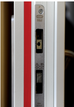
2-flügelige Brandschutztüre EI²30C mit Panikfunktion EN 179. Optik wurde an den Altbestand angepasst. Inklusive Magnethalter: Dieser löst im Brandfall die Türen und mittels Schließfolgeregler werden beide Türflügel richtig geschlossen.
