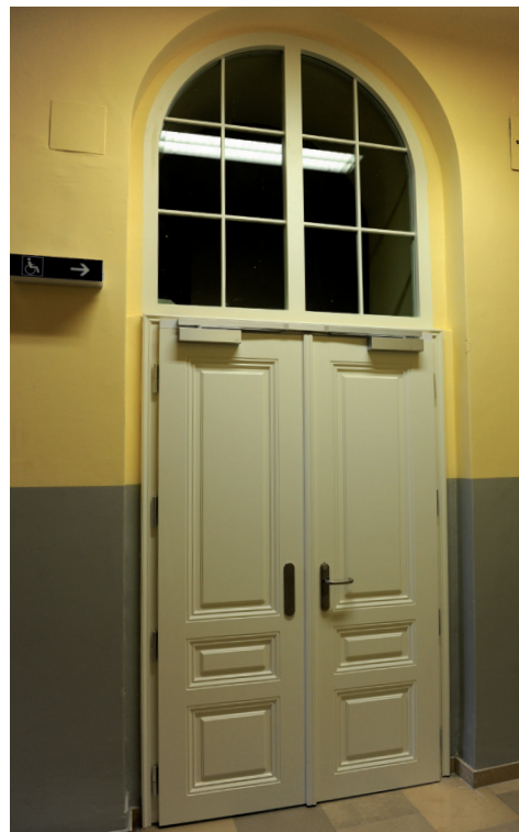
Original nachgebaut: Brandschutz EI²30C mit fixer Oberlichte. Gesamthöhe: 3,8 m.
