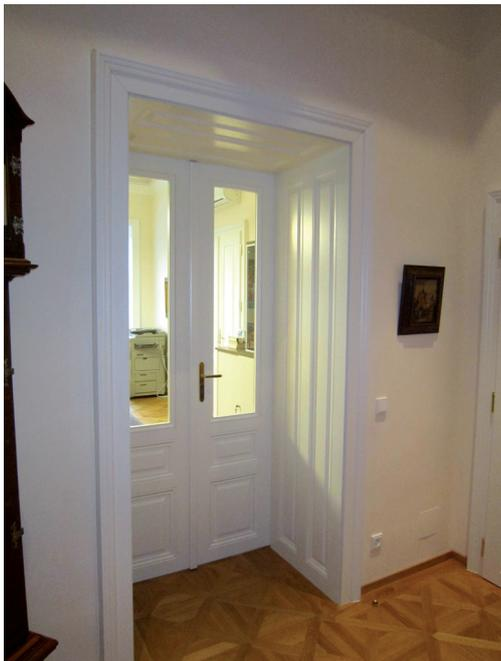
Alt-Wien Doppeltür, oben mit Glas- und unten mit Holzfüllungen, überbreites Stockfutter mit 2 Füllungsfelder und profilierter Zierverkleidung.
