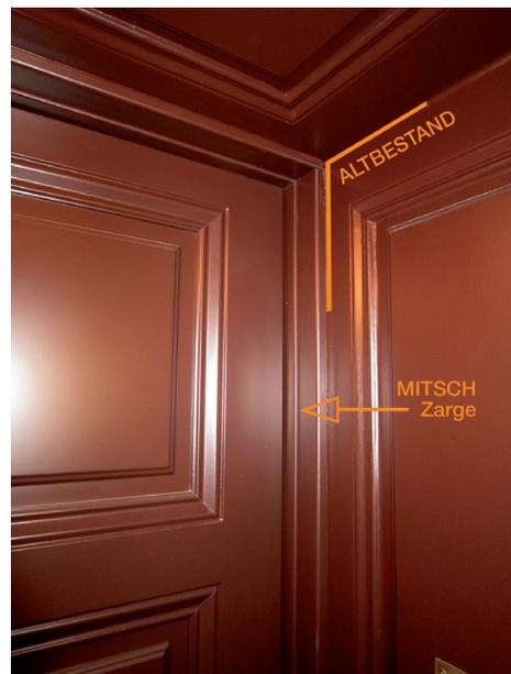
Lösungskompetenz mit Aluminiumzarge: Die Aluzarge von Mitsch ermöglicht es, die historische Zargenverkleidung ganz im Original zu belassen und die neue Tür zu integrieren. Somit bleibt der Charme des alten Gemäuers erhalten. Insgesamt hat Mitsch 20 unterschiedliche Zargenmodelle in Holz als auch in Alu entwickelt, die sowohl im Innen- als auch im Außenbereich eingesetzt werden.
