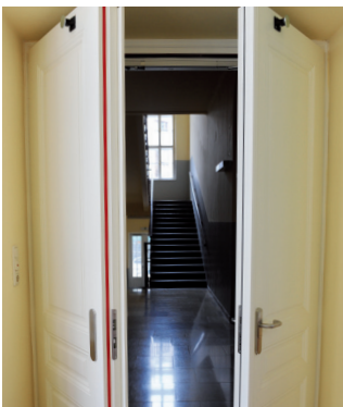
2-flügelige Brandschutztüre EI 2 30C mit Panikfunktion EN 179. Optik wurde an den Altbestand angepasst. Inklusive Magnethalter: Dieser löst im Brandfall die Türen und mittels Schließfolgeregler werden beide Türflügel richtig geschlossen.
