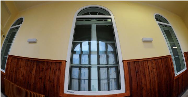
Feuerhemmende F90 Fixverglasung mit Kämpfer (F90 = 90 Minuten Feuerwiderstandsdauer).
