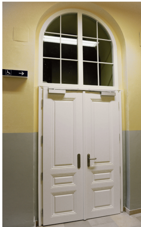
Original nachgebaut: Brandschutz EI 2 30C mit fixer Oberlichte. Gesamthöhe: 3,8 m.
