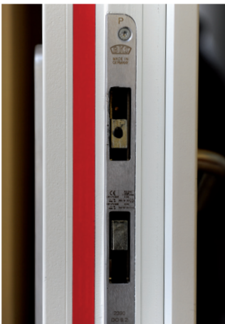
2-flügelige Brandschutztüre EI 2 30C mit Panikfunktion EN 179. Optik wurde an den Altbestand angepasst. Inklusive Magnethalter: Dieser löst im Brandfall die Türen und mittels Schließfolgeregler werden beide Türflügel richtig geschlossen.
