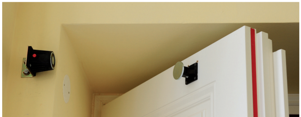
2-flügelige Brandschutztüre EI 2 30C mit Panikfunktion EN 179. Optik wurde an den Altbestand angepasst. Inklusive Magnethalter: Dieser löst im Brandfall die Türen und mittels Schließfolgeregler werden beide Türflügel richtig geschlossen.
